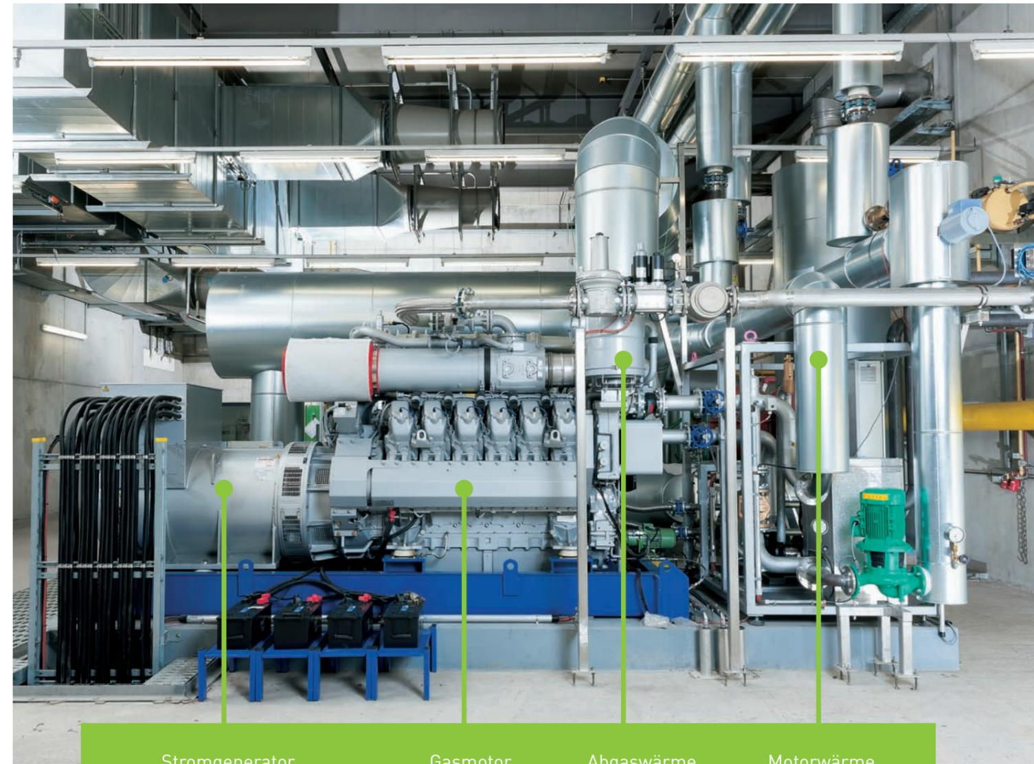
Ein Gasmotor treibt einen Generator zur Stromerzeugung an. Die Abwärme des Motors wird zum Heizen verwendet oder ins Nahwärmenetz eingespeist.
