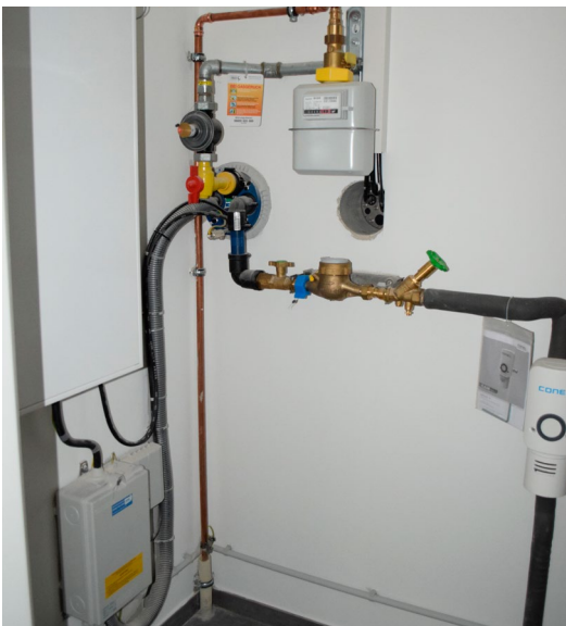
Abbildung 5: Hausanschlussraum
