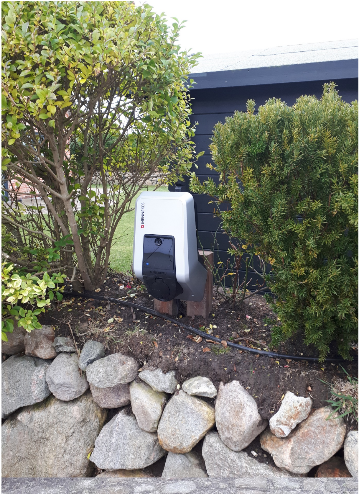
Ferienhaus in Wenningstedt: Aufbau einer Wallbox Amtrom Basic 11 kW Autorisation durch Schlüsselschalter. Installation der Lademöglichkeiten auf Bongossipfählen inkl. der gesamten Arbeiten an der Wallanlage.
