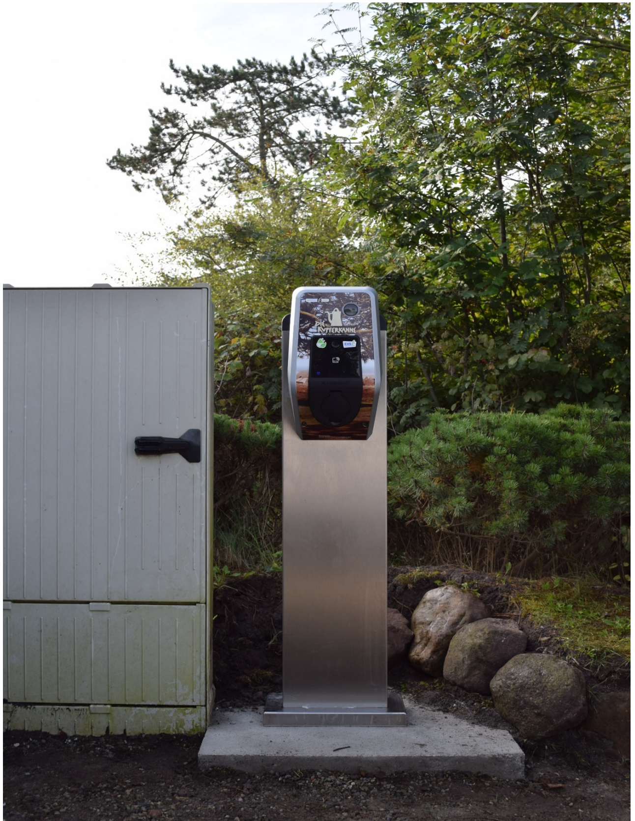
Kupferkanne Kampen: Amtron Premium 11 kW auf Edelstahlsäule mit Kundenbranding. Autorisation mit Kundenkarte ebenfalls mit Kundenbranding. Aufladen des betriebseigenen Kleintransporters sowie für Kunden der Kupferkanne.
