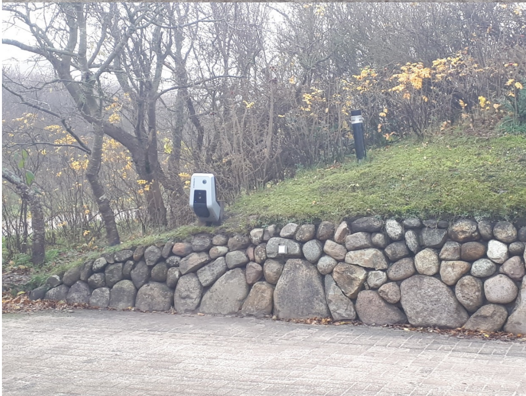
Kampen: Installation von 3 Wallboxen Amtron Premium 11 kW Benutzung durch die Eigentümer bzw. für Feriengäste. Installation der Lademöglichkeiten auf Bongossipfählen inkl. der gesamten Arbeiten an der Wallanlage.
