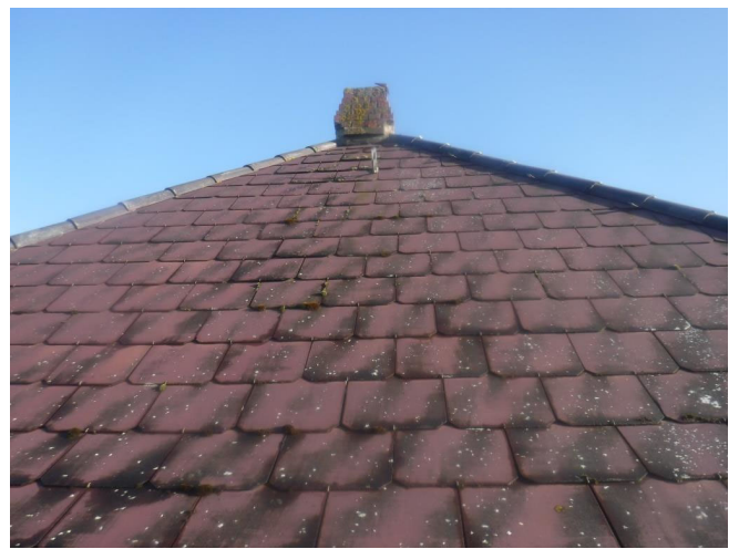
Abb. 20: Asbesthaltige Schindeleindeckung
