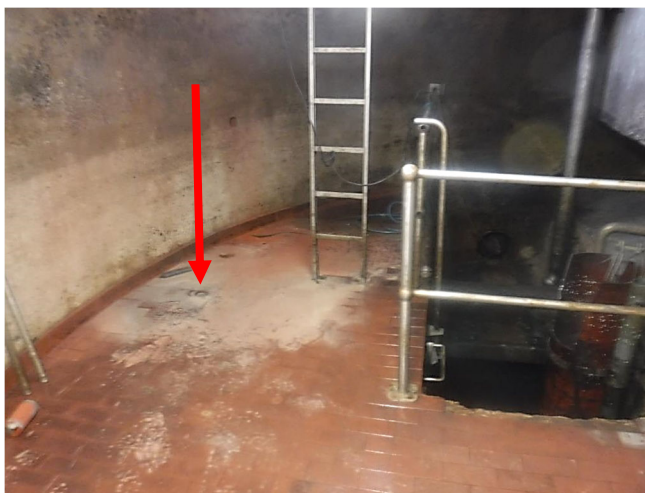
Abb. 11: Untersuchungsstelle Fußbodenaufbau Zwischen- sohle Vorlagebehälter
