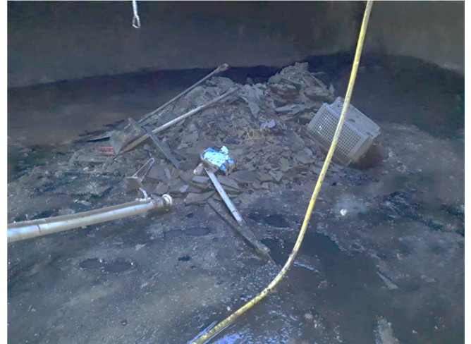
Abb. 4: Im Vorlagebehälter angetroffene Anhäufung von Beschichtungsüberresten, Schlammrückständen und Unrat
